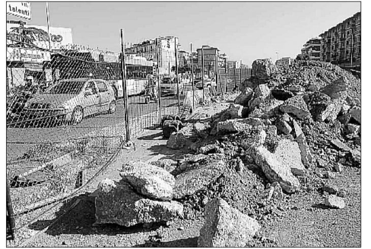
Lavori per la tramvia all'Isolotto. Da domani chiusa piazza Batoni
