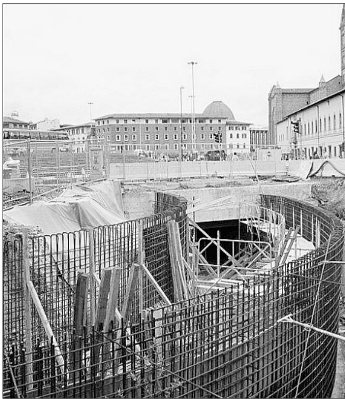
I cantieri della Tramvia presto apriranno anche nel viale Morgagni
